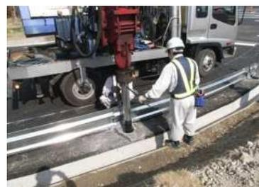
土中に防護柵支柱を打設している状況です。
