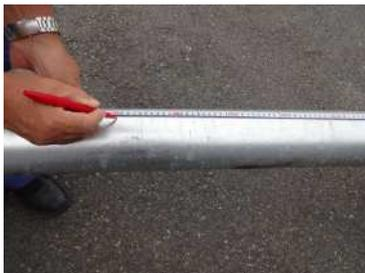
RPの装着固定位置を確認し、支柱に対して垂直に装着できるように、マーキング又は治具等で位置決めをします。
